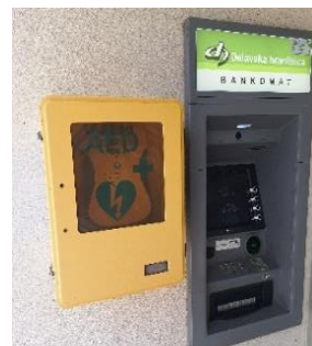
Defibrilator na pročelju Občinske stavbe.
