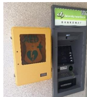
Defibrilator na pročelju Občinske stavbe.
